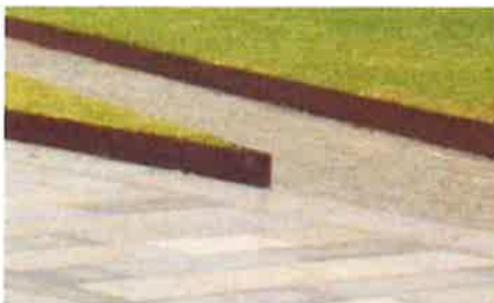
E3 - UNTREATED STEEL EDGING
