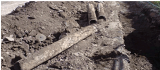
Asbestos pipes
