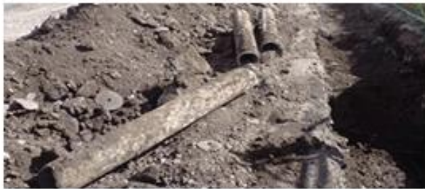
Asbestos pipes
