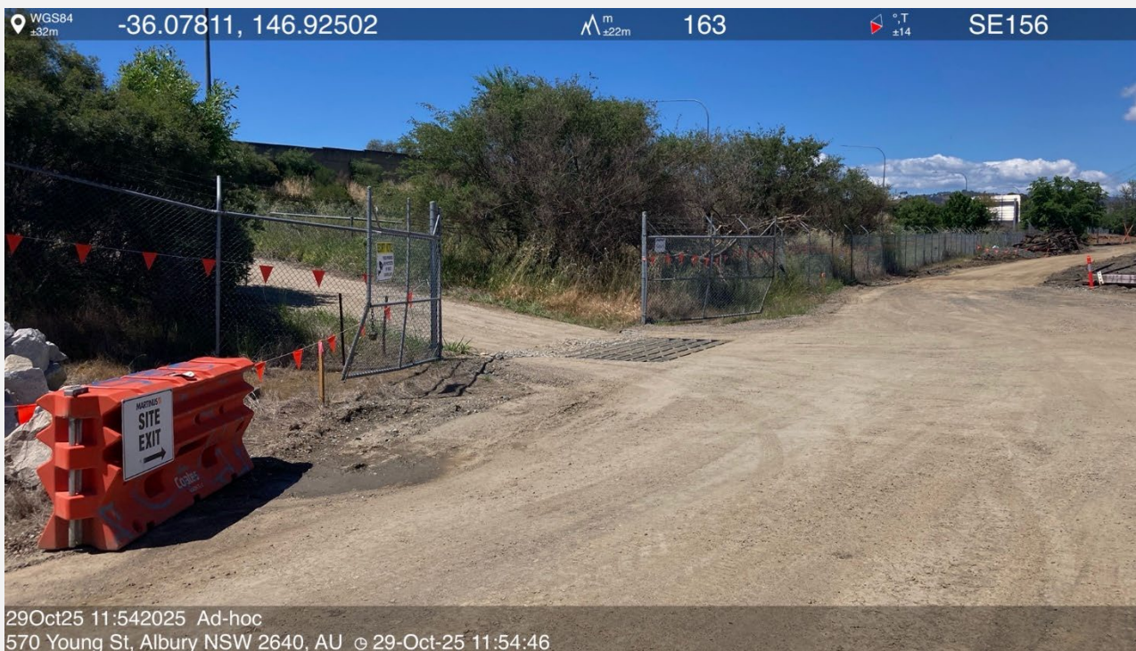
Site egress rumble grid
