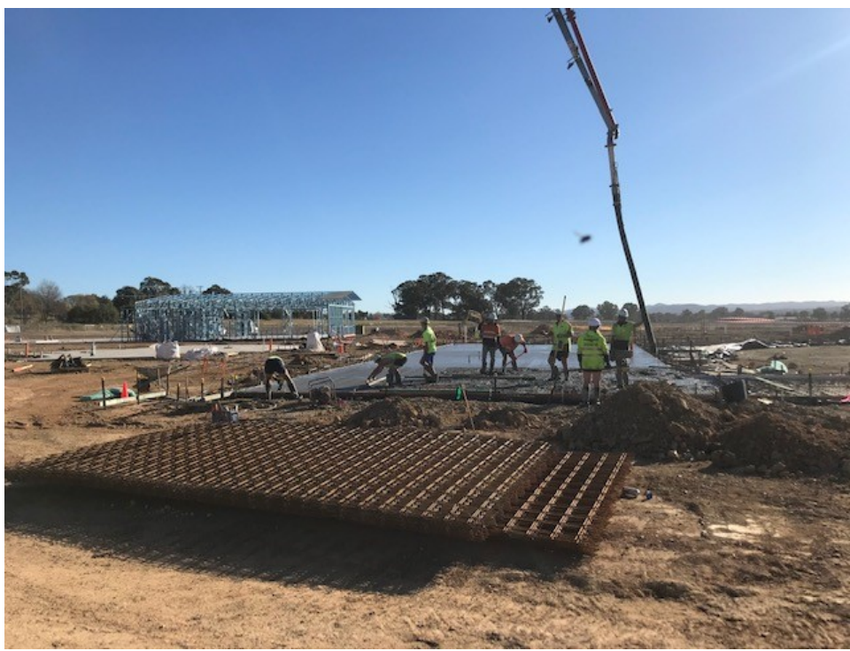
Photo 13– Pouring of concrete slab.
