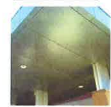
ALS ALUMINUM CLADDING TO MAIN AWNING SOFFIT
