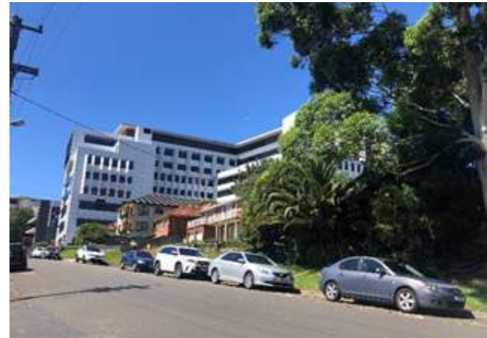
Western edge view
