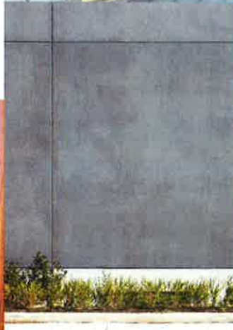
PRECAST CONCRETE (WALL)
