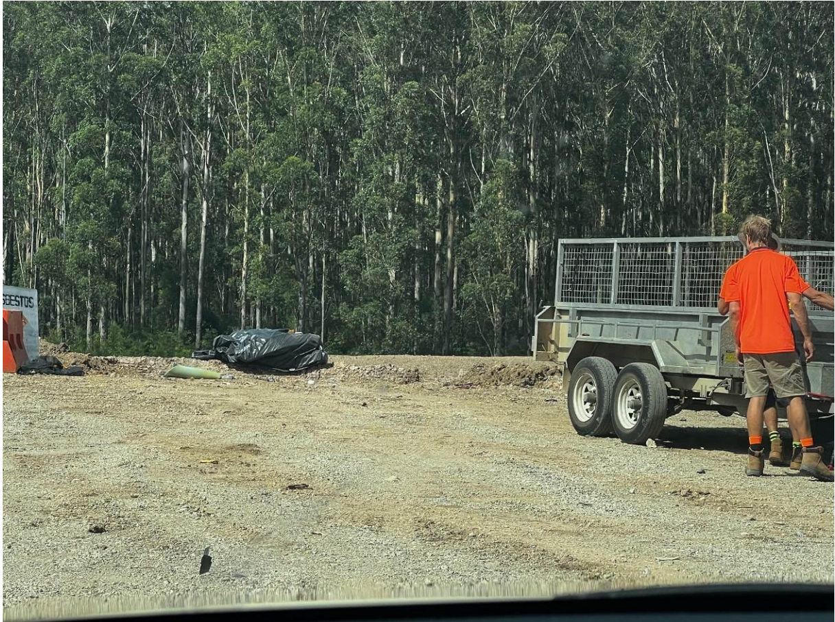
Disposal of asbestos.
