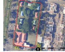
Аэрофотосъёмка площадки в 2013 году
