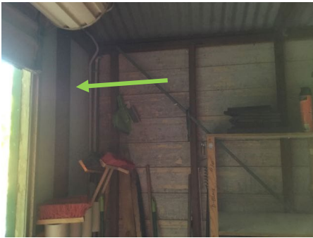
Photo No. 014: Inside left roller door
