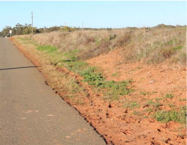
1. Nyngan flood levee.
