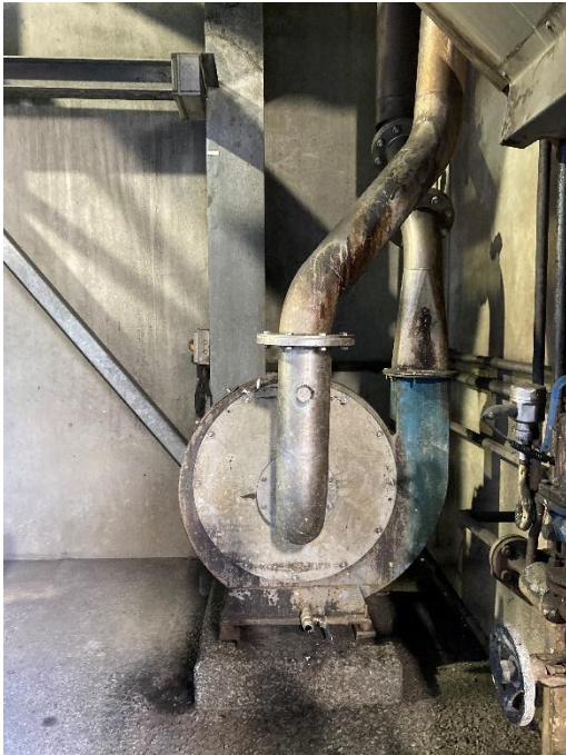
DDG 3 – Air Leakage Fan
