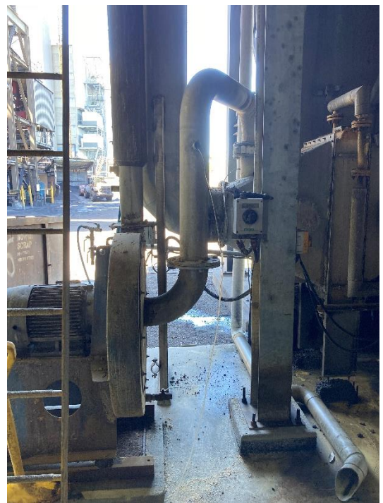
DDG Dryer 1 & 2 – Air Leakage Fan
